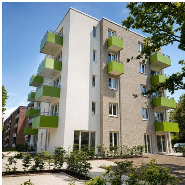
Anbau Goethestraße 1a in Hiddenhausen ↑ nach Fertigstellung im Juni 2026
