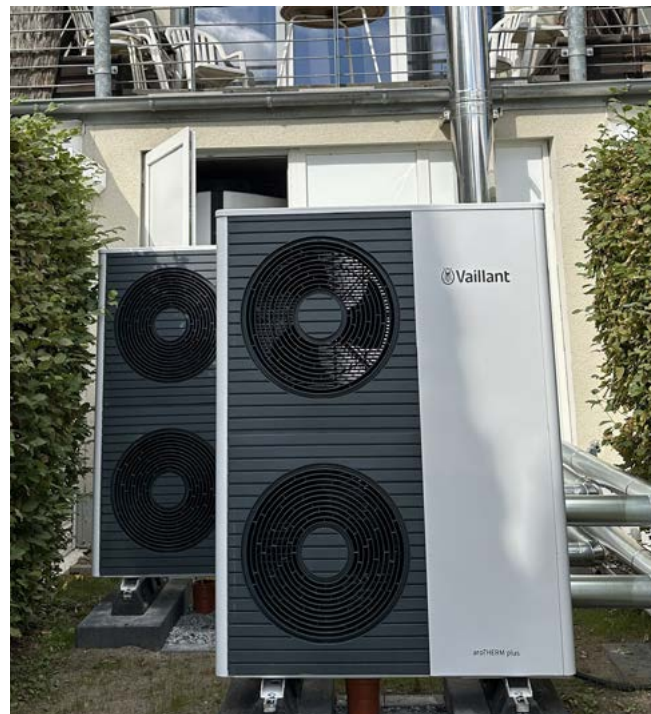
Erneuerung der Heizung: Einbau einer Wärmepumpe ↑ in der Weseler Straße in Bünde (19 Wohneinheiten)
