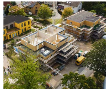
↑ Luftaufnahme der Baustelle an der Adlerstraße
