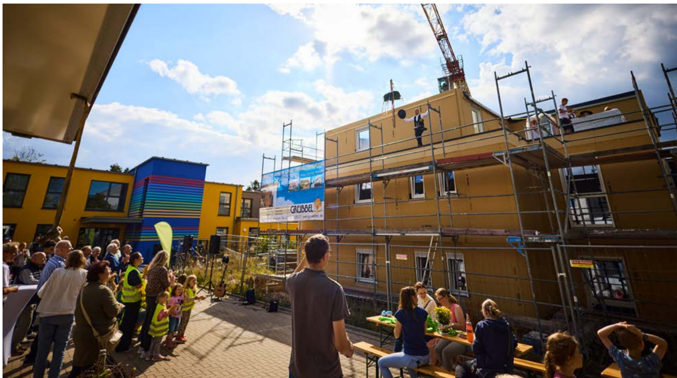
↑ Quartiers- und Richtfest an der Adlerstraße in Enger im September 2025
