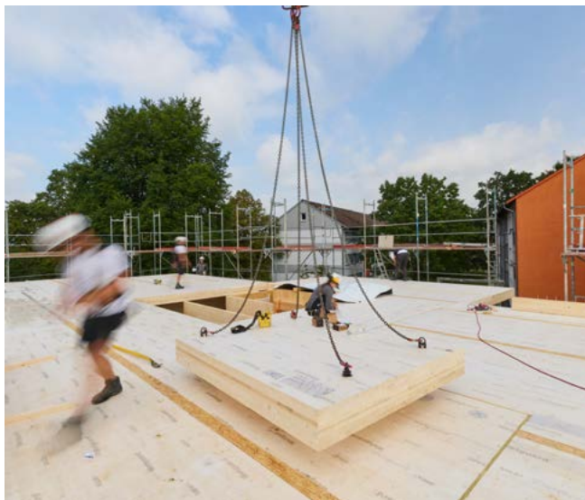
↑ Baustelle im Juli 2025: Zwei neue Gebäude entstehen in Holzrahmenbauweise
